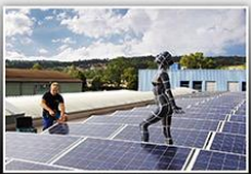
SOLAR PHOTOVOLTAIC INSTALLER Partner: ElektroMa GmbH / www.elektroma.de Location: Firmengebäude, Hameln Model: Lara / Photovoltaik Installateur: Alexander
